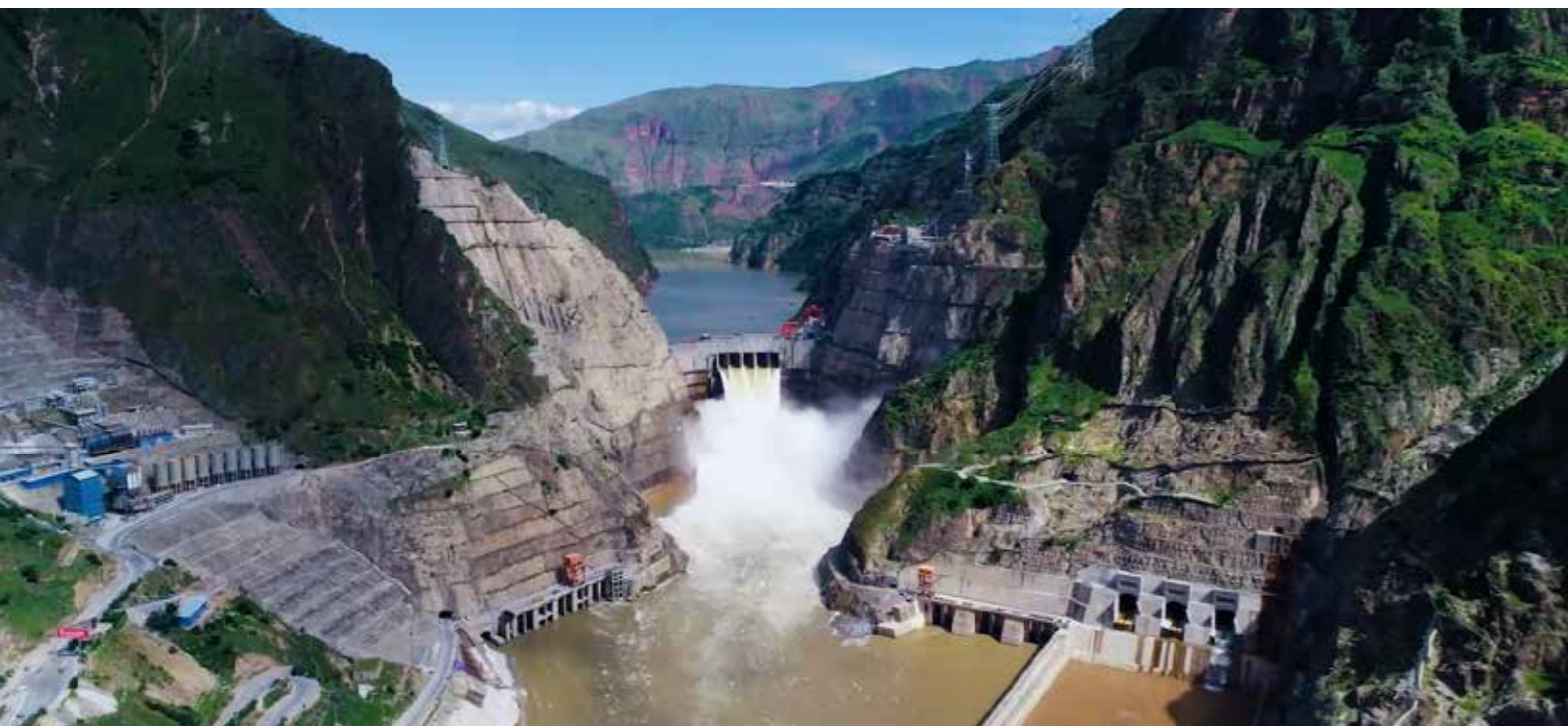
2020年6月29日，国家重大工程——乌东德水电站首批机组投产发电
